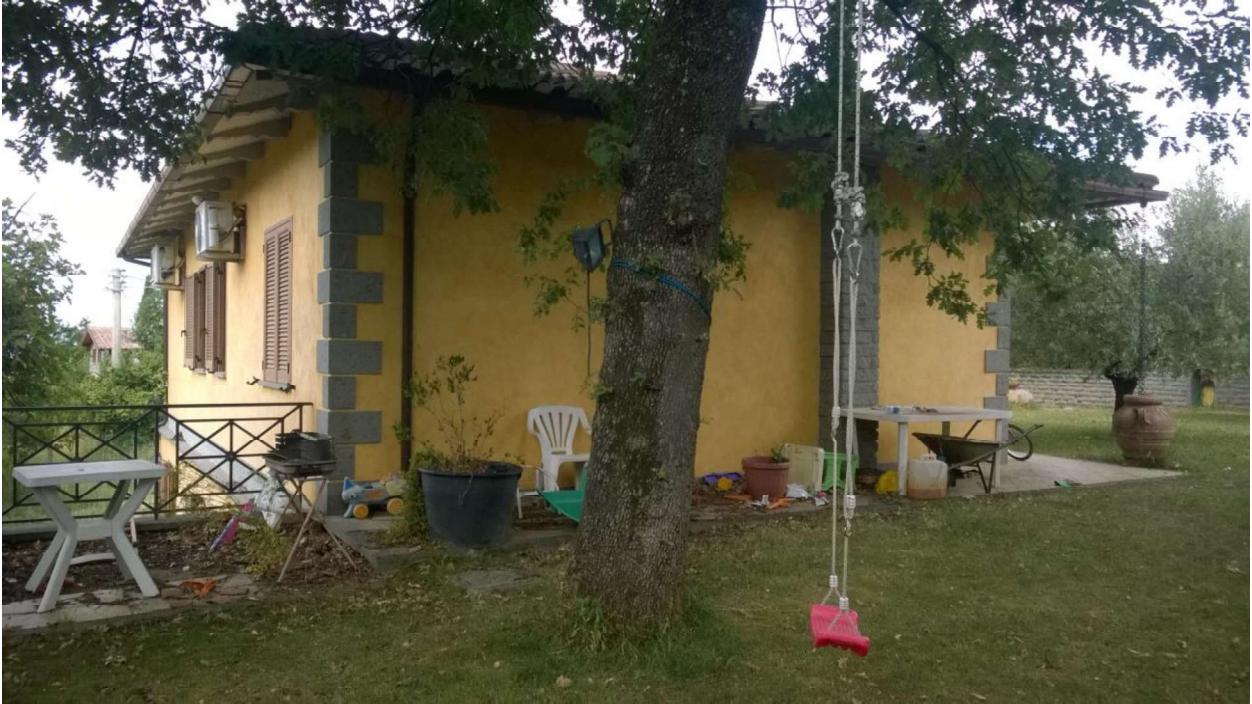
foto 3 – vista lato sud/est villino da giardino pertinenziale (part.lla 648 - 371)
