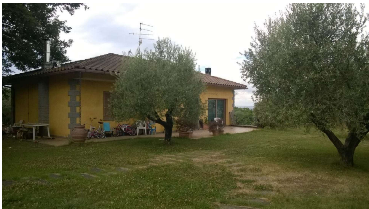
foto 2 – vista villino da giardino pertinenziale (part.IIa 648 - 649)
