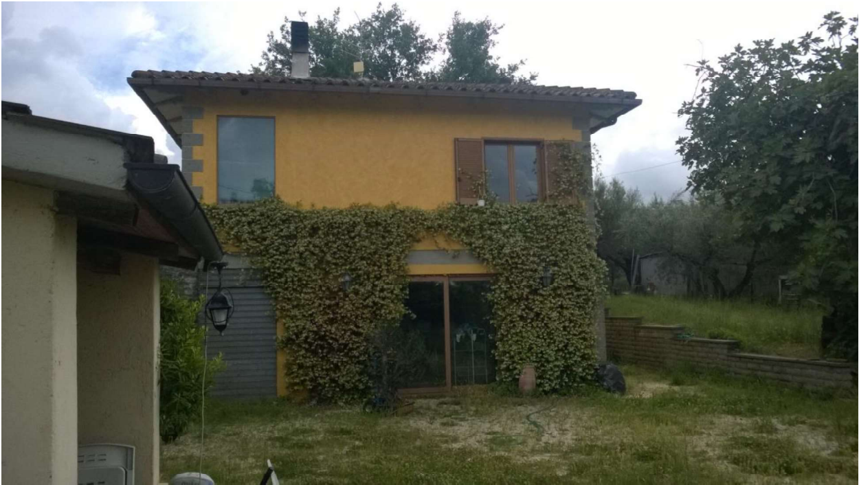
foto 5 – vista lato nord/ovest villino da giardino pertinenziale (part.IIa 648 - 649)
