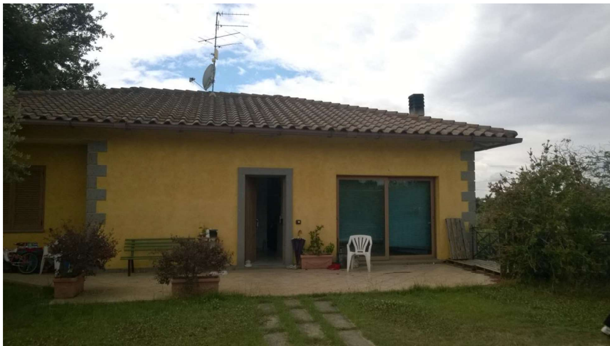
foto 1 – vista ingresso villino da giardino pertinenziale (part.IIa 648)
